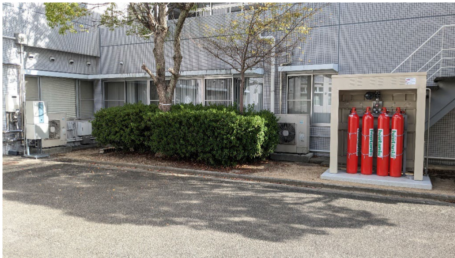
（神戸高専 実証実験の現場の様子）
